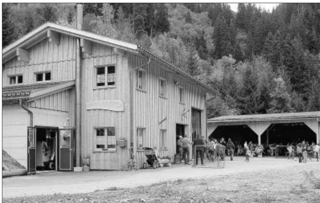
Einheimisches Holz verwendet: Der neue Forstwerkhof von Maladers passt gut in die Umgebung.
